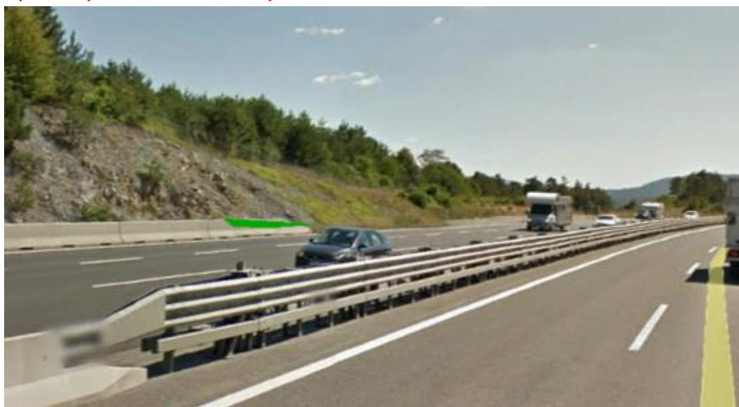
Demontažni prehod na odseku Izola-Jagodje. Za priključkom Izola proti Portorožu.
