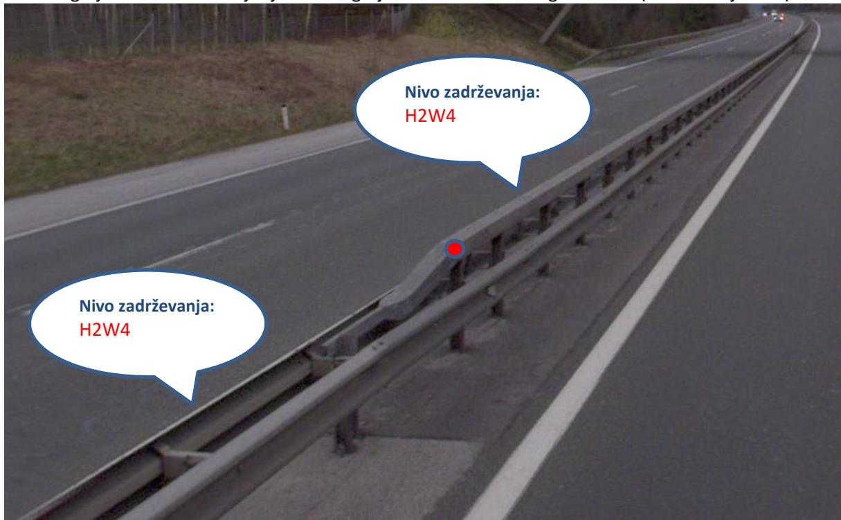
Višino ograje izmerimo do najvišje točke ograje - do višine celotnega sistema (dodatne ojačitve)
